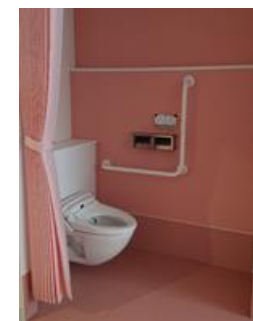
居室内トイレ
