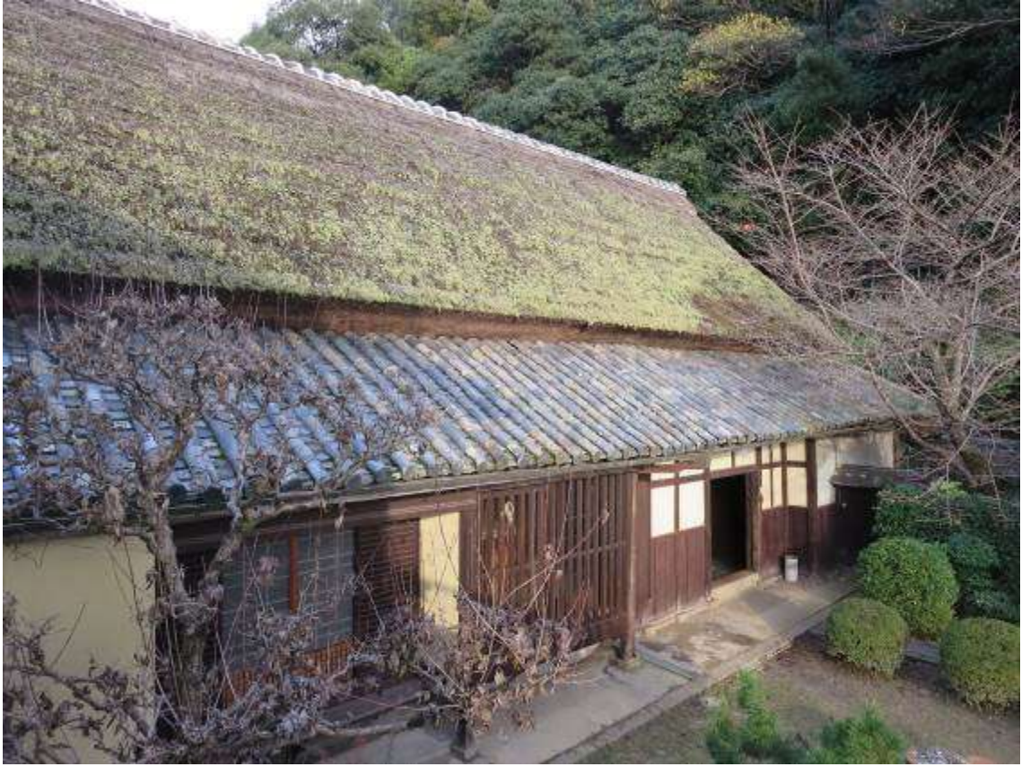
写真5 安田家住宅 主屋
