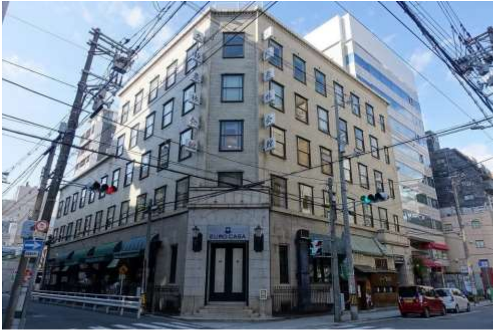
写真3 大阪農林会館ビル
