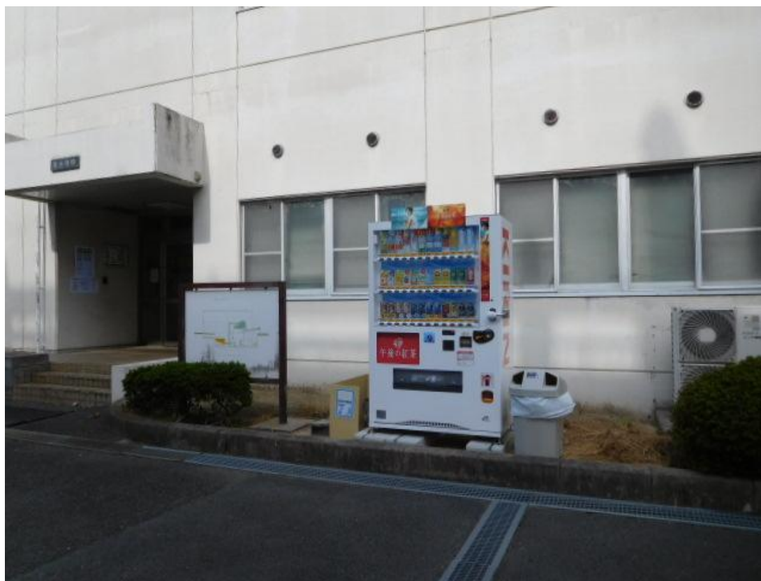
物件番号②（渚水みらいセンター 脱水機棟前）
