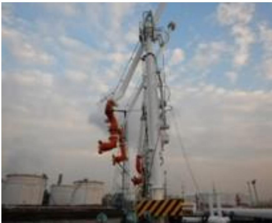
海上栈橋 緊急離散システム搭載ローディングアーム
