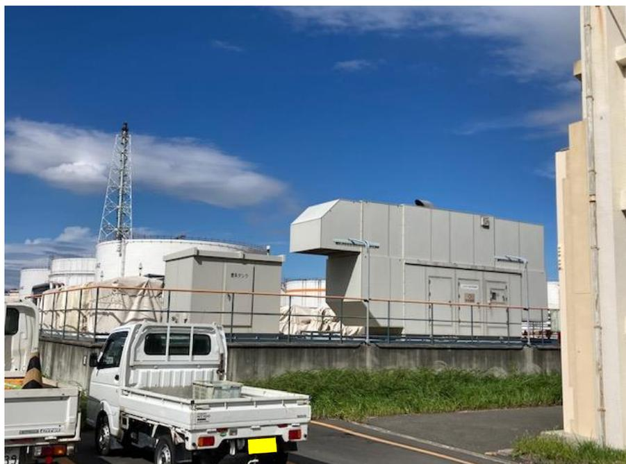
操油計器室 非常用発電機(1基) 800KW
