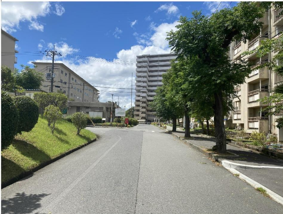
③戸建てと接する道路から1期住棟をみる
