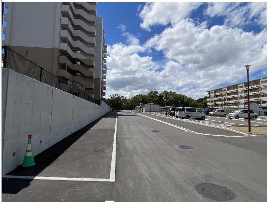
⑪2期北側通路を見る。レベル差を擁壁で処理
