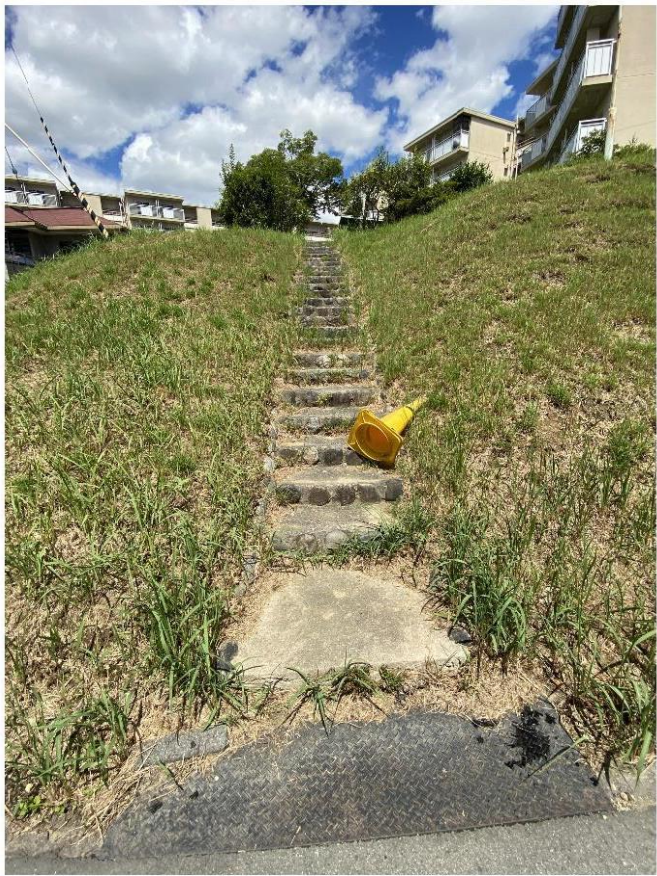
⑯防災公園の既存階段
