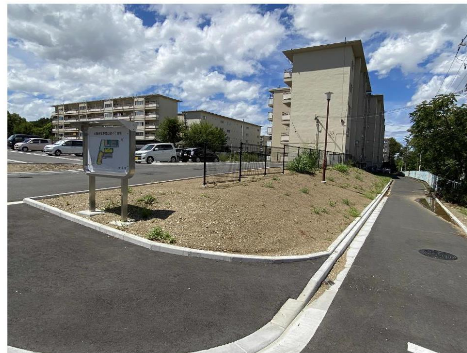
⑫2期敷地北東角から既存住棟をみる
