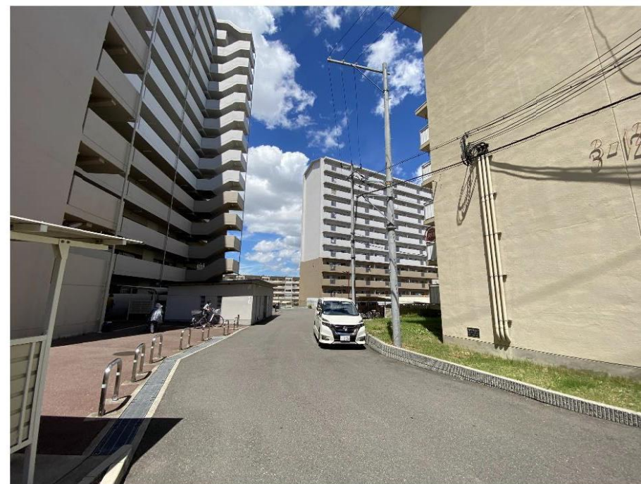
⑩3期通路から1.2期通路を見る
