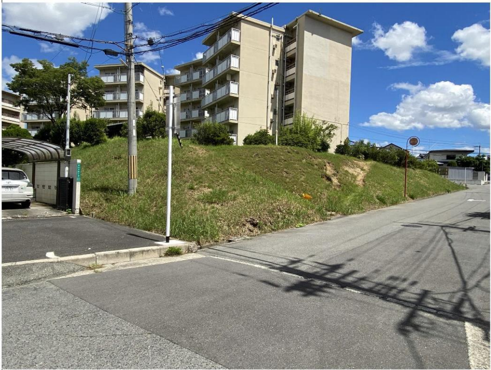
⑮敷地南側より将来整備予定の防災公園をみる
