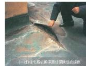
マンション屋上のシート防水接合部が剥がれて躯体が露出し、住戸（専有部分）に雨漏りが発生
