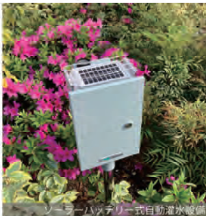
ソーラーバッテリー式自動灌水設備
