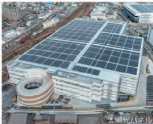
太陽光パネル
