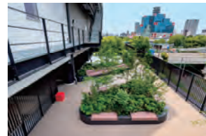
ベンチなどの潤いのある屋上庭園
