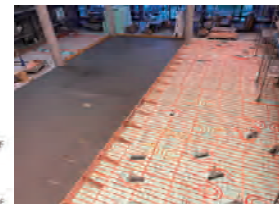
【床放射空調の施工状況】
