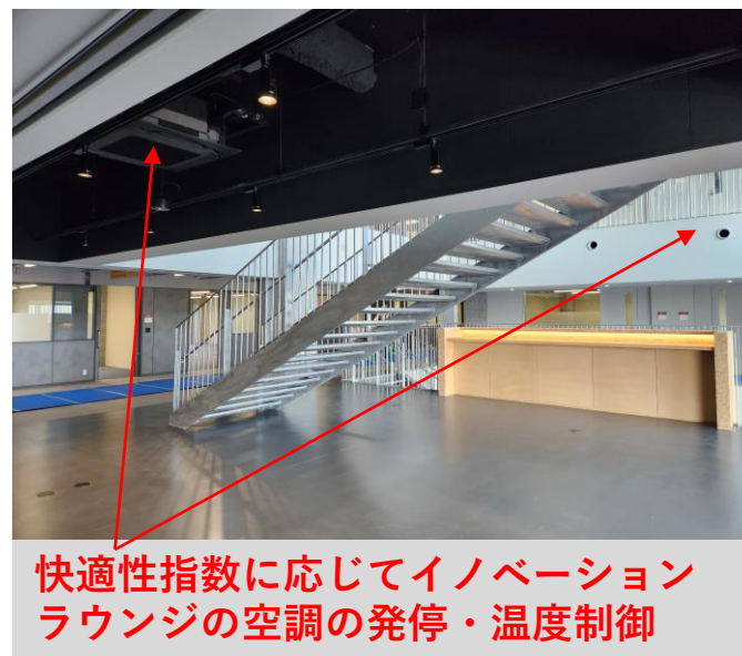
屋内空調吹出し
