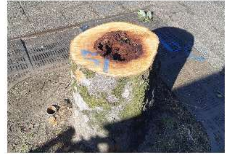
空洞化が進んでいた木（倒木の恐れあり）まちを整備することで危険を未然に防止
