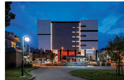
北棟夜景：分節されたボリュームが積層することで、まちへの圧迫感を低減
