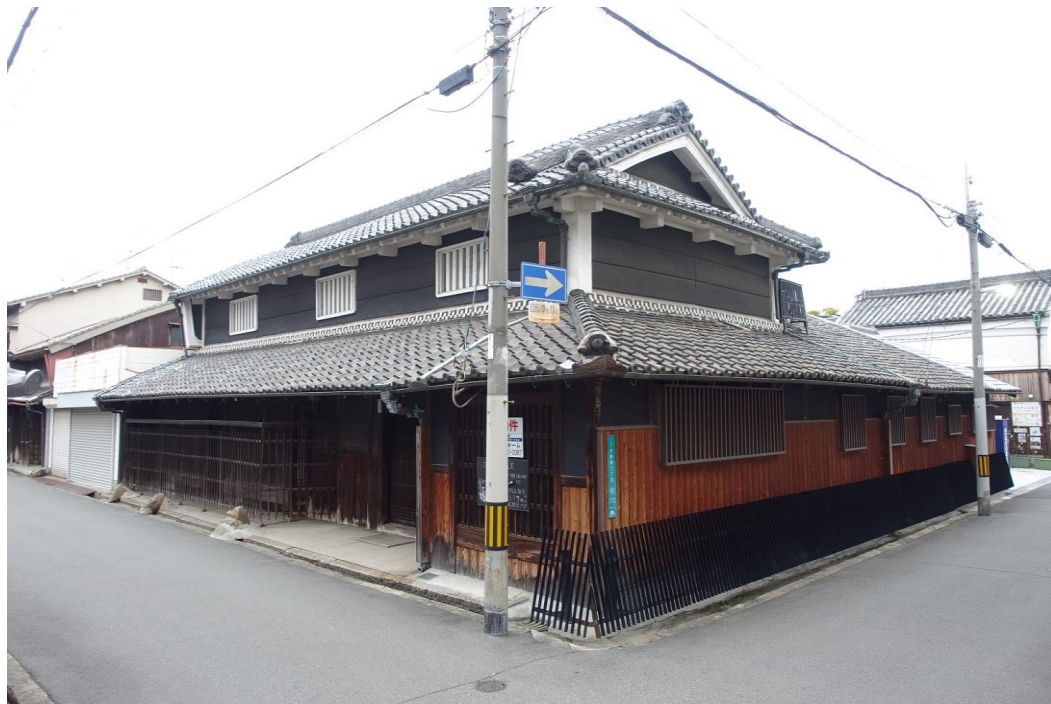
写真1 戎井家住宅主屋
