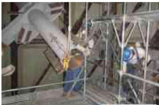
図3-27 (ア) 鉄骨補強材の搬入
