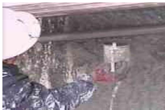
図 3-13 下地吹き付け作業
