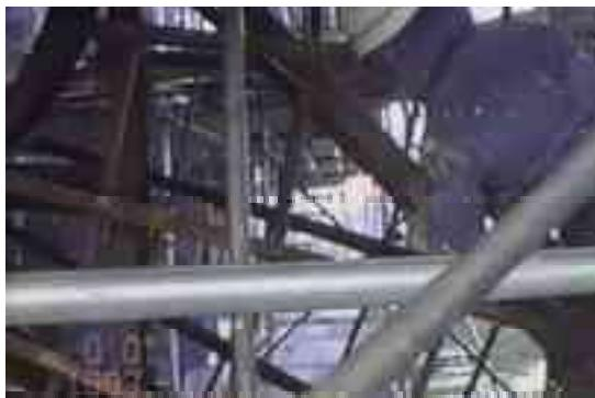
図 3-17 鉄骨下地 ケレン作業
