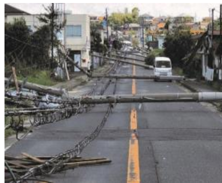
平成30年 台風21号による 電柱倒壊等による道路閉塞
