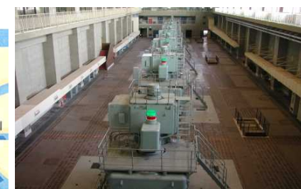
主ポンプ設備6台 口径Φ4000mm×4枚羽根分 総排水量55m³×6台 330m³/s
