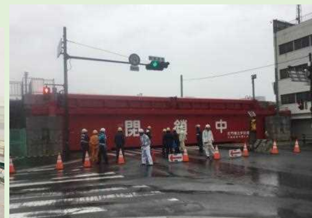
左門橋左岸 (左門殿川)
