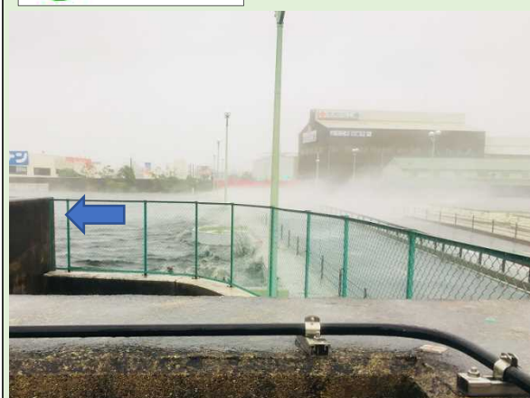
鉄扉閉鎖時の左門殿川の様子
