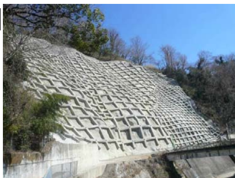
法面保護対策（令和4年度完了）
