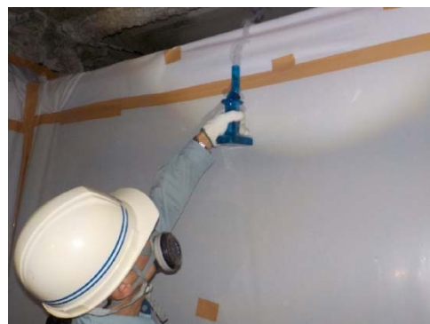
解体現場への立入検査 （アスベスト工事での養生状態の検査）
