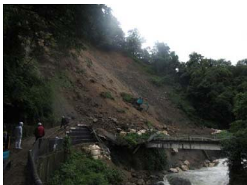
崩落した法面・落石防護施設等
