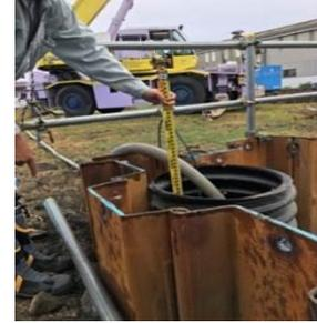
汚染土壌掘削工事の現地確認状況(地下水位の確認)
