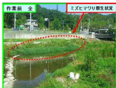
作業前の状況
