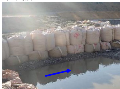
大型土のうによる仮設水路設置状況（穂谷川新橋上流）
