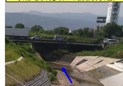
改修後(穂谷川新橋付近)
