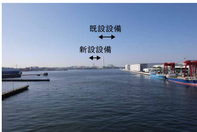
③南港大橋
