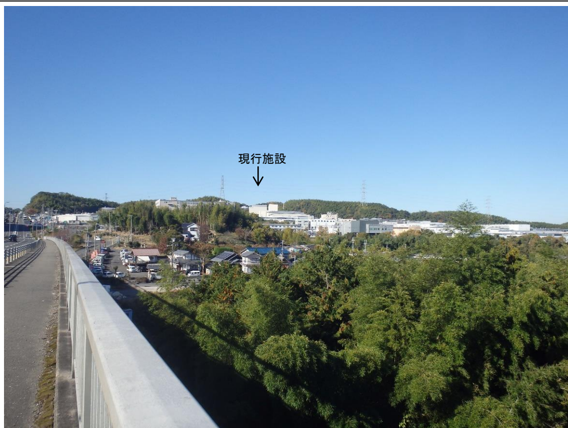
㊸松尾川大橋(国道 170 号)の現況(秋季)
