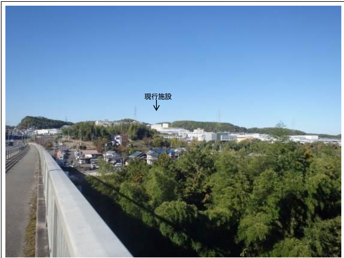
㊸松尾川大橋(国道 170 号)の現況(秋季)
