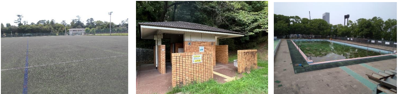
図 3.5-1 公園サービス施設等の劣化状況
