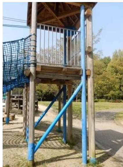
図 2.2-26 遊具の長寿命化に資する工夫事例
