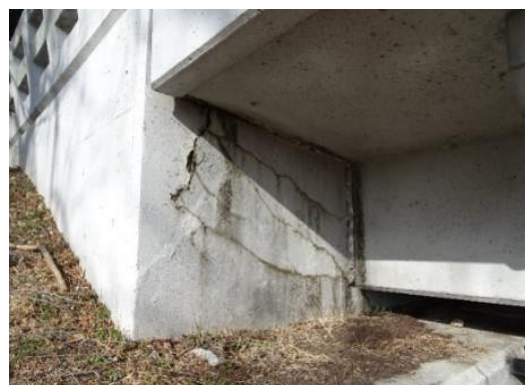
図 3.3-1 橋梁の劣化状況
