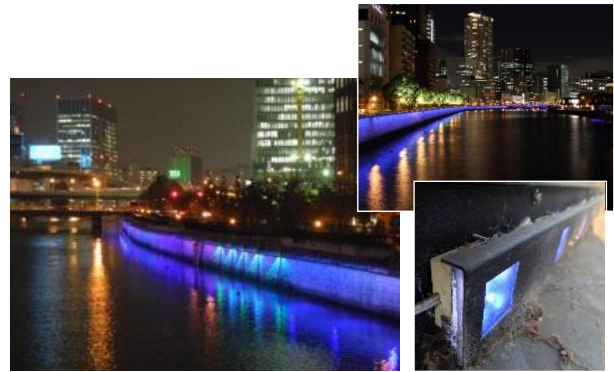
護岸照明施設（大川、堂島川）
