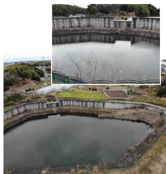
住吉川防災調節池
