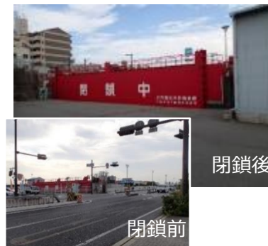
神崎川左門橋左岸鉄扉 (コンクリート部等)
