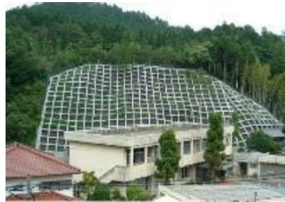
急傾斜地崩壊防止施設
