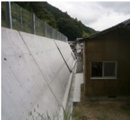
急傾斜地崩壊防止施設 (擁壁工)
