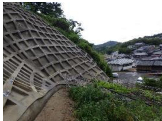
急傾斜地崩壊防止施設 (法枠工)
