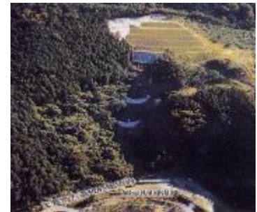
地すべり防止施設
