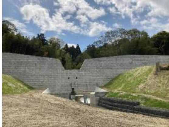
不透過型砂防堰堤
