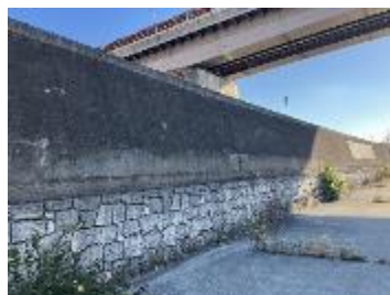
特殊堤（コンクリート）
