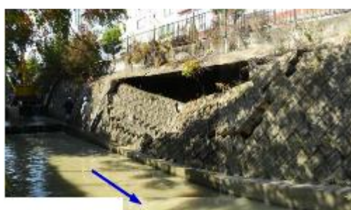
図 3.1-5 護岸の崩壊
