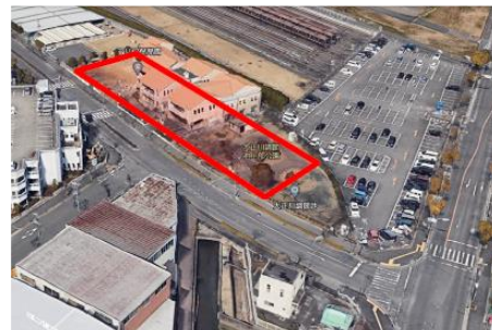
地上の状況 (大正川調節池)
