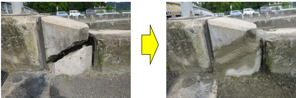
図 3.1-35 直営作業による補修（橋梁地覆取付け部のモルタル処理）
