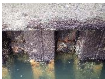
鋼材の腐食
