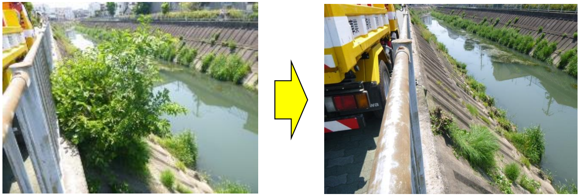
図 3.1-37 直営作業による雑木の伐採
