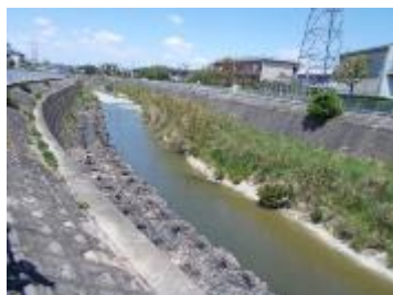
護岸（特殊堤を除く）
