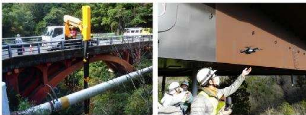
図 3.1-5 橋梁の点検実施状況
