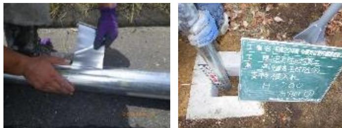
図 3.7-3 防食テープの設置
