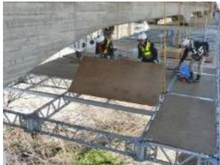
図 3.9-23 安全性向上：パネル足場
