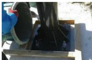
図 3.7-4 無収縮モルタルの充填
