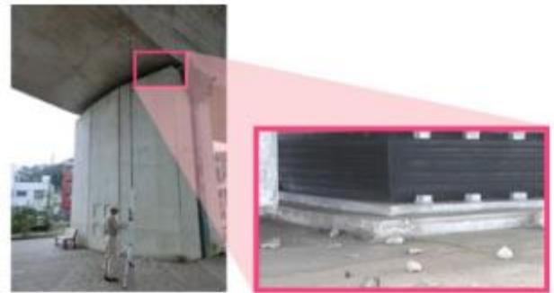
図 3.9-21 点検ロボット
