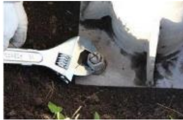
図 3.7-2 ボルト・ナットの増し締め
