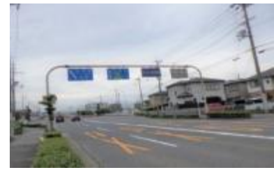
門型標識 道路標識 岸和田牛滝山貝塚線／岸和田市
