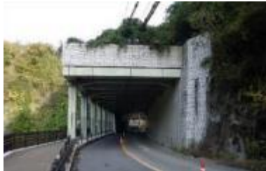
シェッド 箕面洞門 豊岡亀岡線／箕面市
