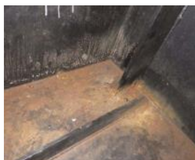
内部の腐食
