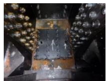
内部の腐食
