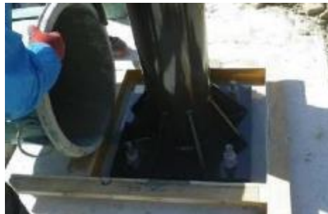
図 3.5-6 無収縮モルタルの充填
