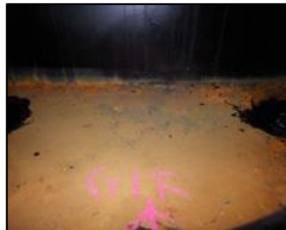
内部の腐食
