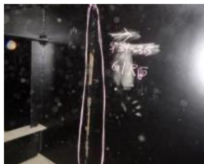
内部の腐食
