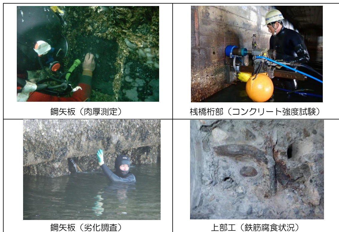
図 3.1-16 詳細点検（委託）の現状
