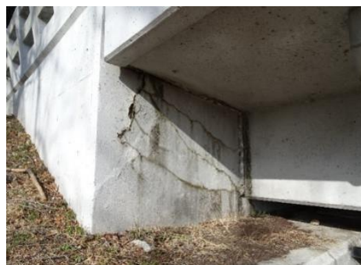
図 3.3-1 橋梁の劣化状況
