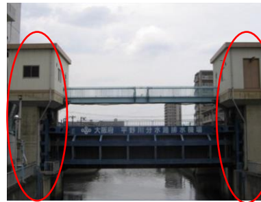
平野川分水路排水機場
