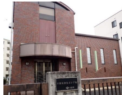
平野川浄化ポンプ場
