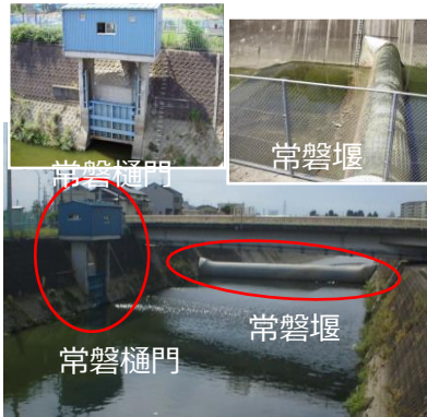
西除川常盤堰・常盤樋門
