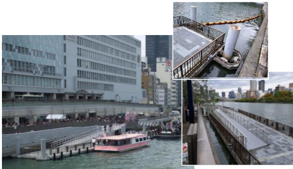
「八軒家浜防災船着場（浮棧橋）」
