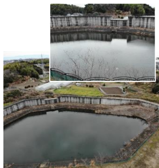
住吉川防災調節池
