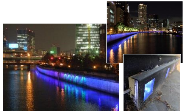
護岸照明施設（大川、堂島川）
