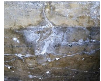
ASR（今川立坑）
