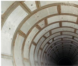
鋼材の発錆（久宝寺調節池）
