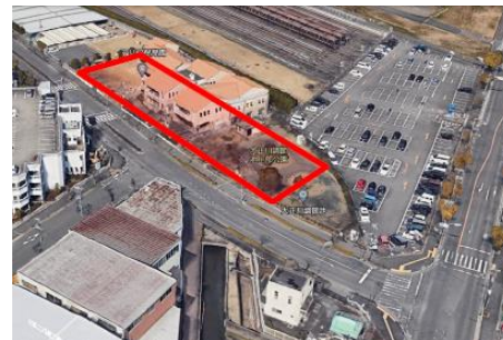
地上の状況 (大正川調節池)
