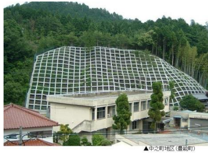
急傾斜地崩壊防止施設
