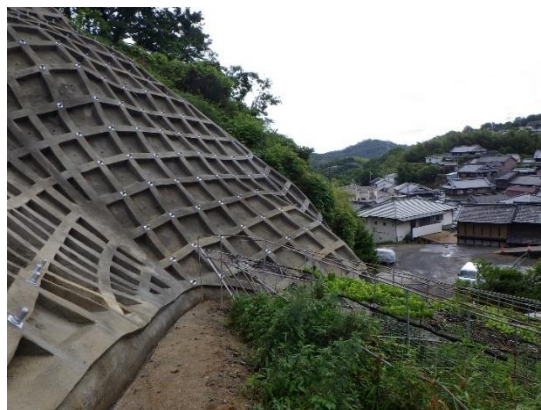
急傾斜地崩壊防止施設 （法枠工）
