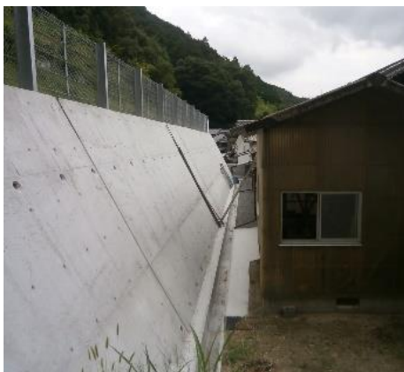
急傾斜地崩壊防止施設 （擁壁工）
