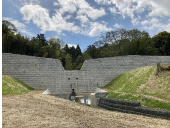
不透過型砂防堰堤
