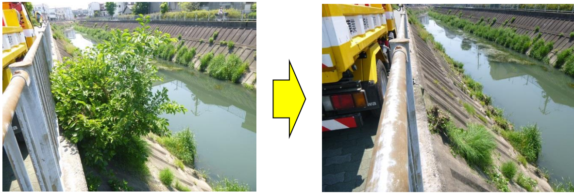
図 3.1-37 直営作業による雑木の伐採
