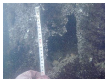
鋼材の貫通孔（水中部）
