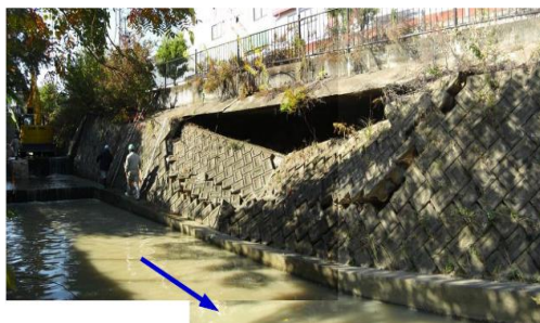
図 3.1-5 護岸の崩壊
