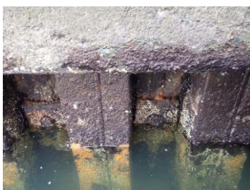
鋼材の腐食
