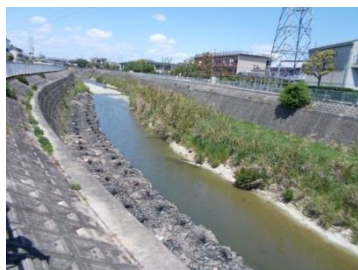
護岸（特殊堤を除く）
