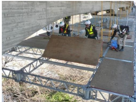
図 3.9-23 安全性向上：パネル足場
