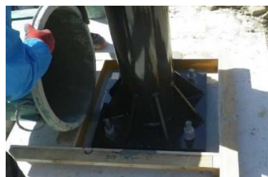
図 3.7-4 無収縮モルタルの充填
