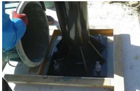
図 3.5-6 無収縮モルタルの充填
