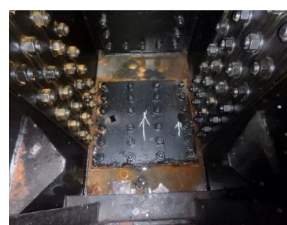
内部の腐食
