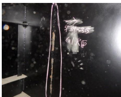
内部の腐食
