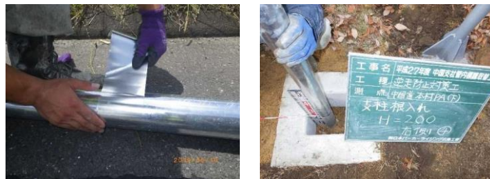
図 3.7-3 防食テープの設置
