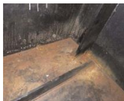
内部の腐食
