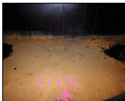
内部の腐食
