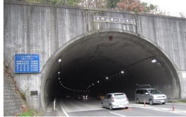
トンネル 天野山第一トンネル 170号／河内長野市
