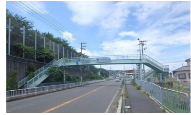
横断歩道橋 箱作横断歩道橋 和歌山阪南線／阪南市
