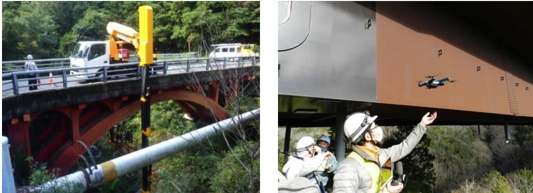
図 3.1-5 橋梁の点検実施状況
