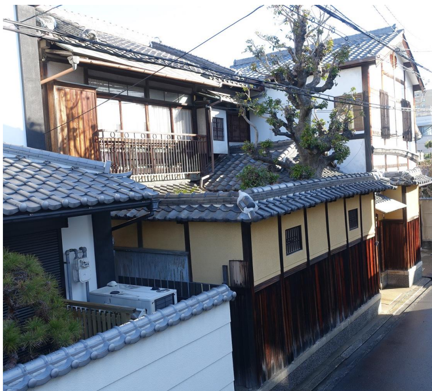
写真1 戸田家住宅（旧服部家住宅）主屋
