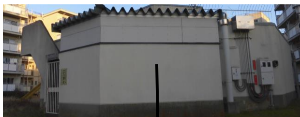
③ 給水塔修繕一般
