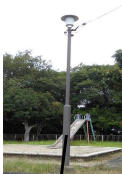
② 外灯ポール取替 (腐食等危険性のあるもの)
