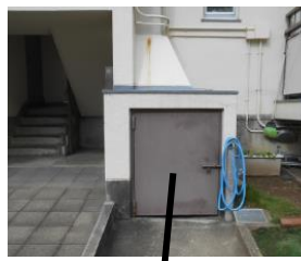
⑤ダストシュート修繕
