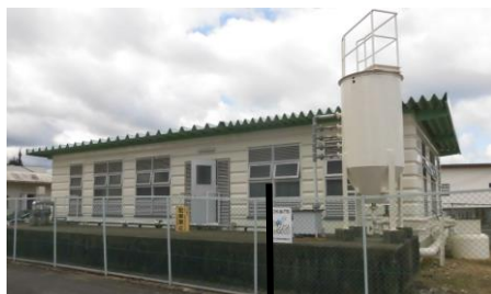
④ 浄水槽修繕一般
