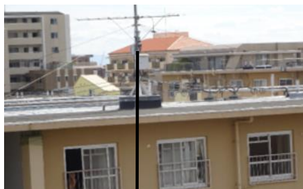
⑥ テレビ共同受信アンテナ (府で設置したもの)
