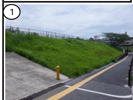
堤体状況(北堤)
