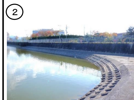
堤体状況(西堤)
