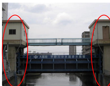
平野川分水路排水機場
