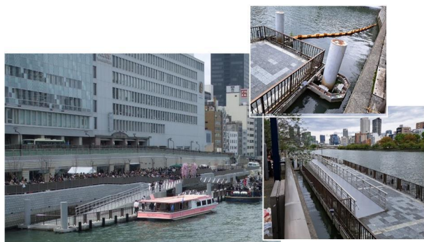
「八軒家浜防災船着場（浮棧橋）」
