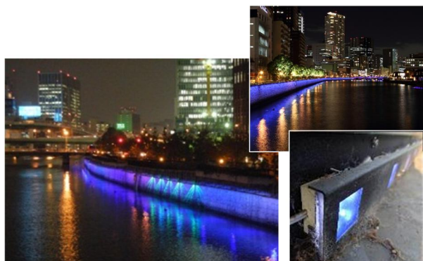
護岸照明施設（大川、堂島川）
