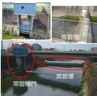
西除川常盤堰・常盤樋門
