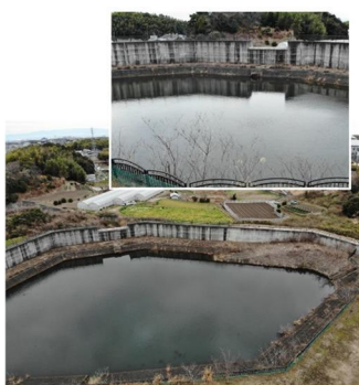
住吉川防災調節池
