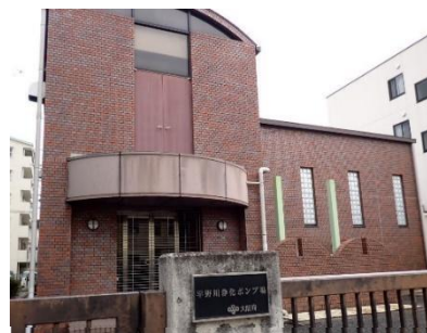
平野川浄化ポンプ場
