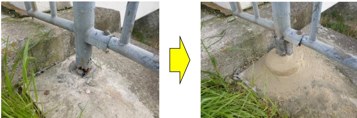
写真 3.1.6-3 直営作業による柵補修（支柱腐食箇所の補修）
