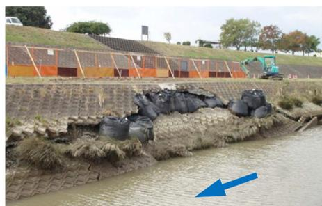
写真3.1.1-3 護岸の崩壊
