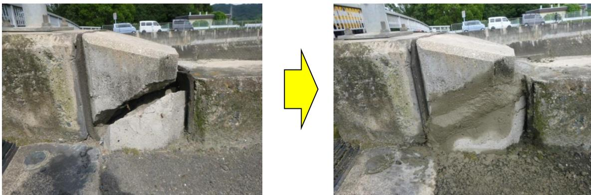
写真 3.1.6-2 直営作業による補修（橋梁地覆取付け部のモルタル処理）
