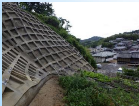
急傾斜地崩壊防止施設 (法枠工)
