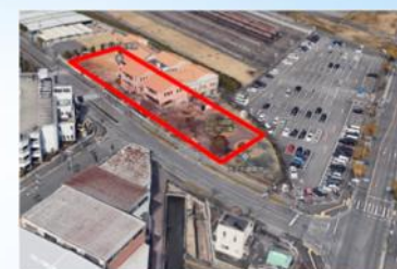
地上の状況（大正川調節池）
