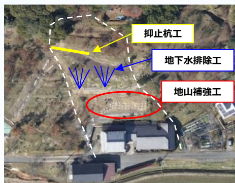
地すべり対策施設 (杭工・地山補強工・地下水排除工)
