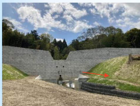
不透過型砂防堰堤
