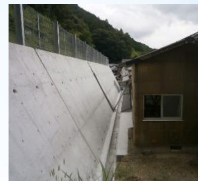
急傾斜地崩壊防止施設 (擁壁工)
