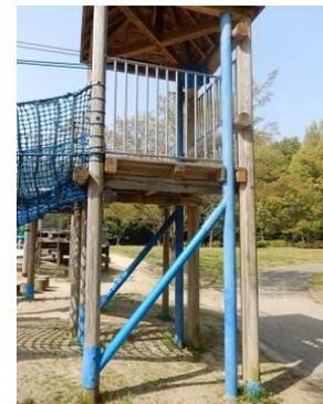
構造部材（支柱）を新たに追加補修し、遊具の延命を図る。
