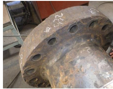
ポンプ軸の腐食状況
