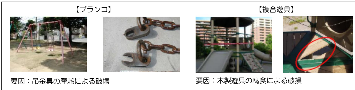
写真2.2-4 遊具の事故事例
