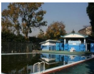
プールから遊戯広場に再整備
