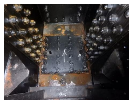
内部の腐食
