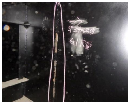
内部の腐食
