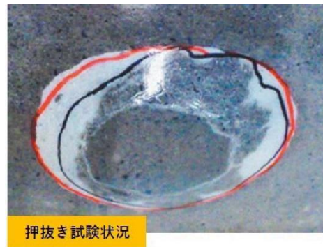
図 3.9-23 品質向上：剥落防止（透明・冬季施工可能）
