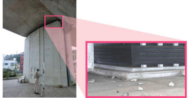
図 3.9-19 点検ロボットカメラ
