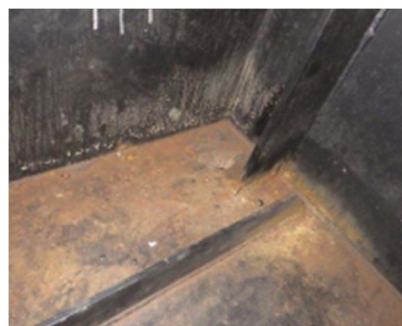
内部の腐食
