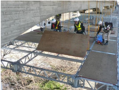
図 3.9-20 安全性向上：パネル足場
