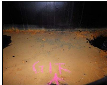
内部の腐食
