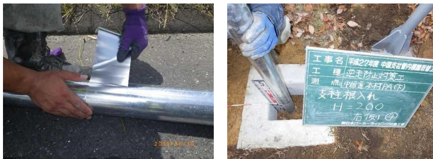
図 3.7-4 防食テープの設置
