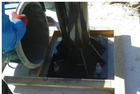
図 3.7-3 無収縮モルタルによる充填
