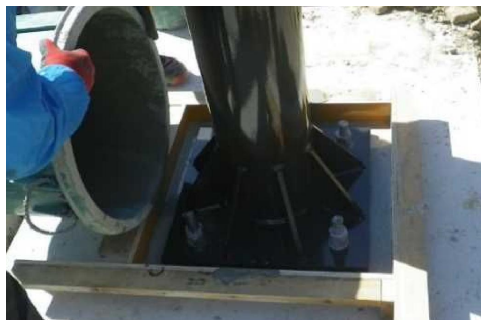
図 3.1-7 無収縮モルタルによる充填
