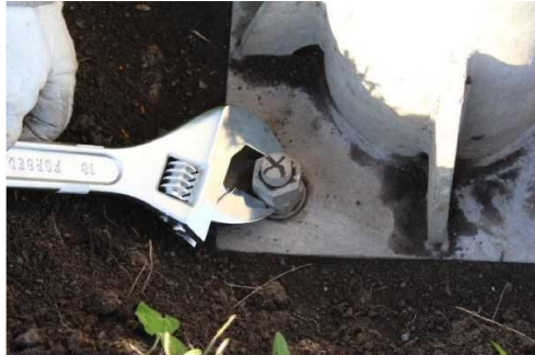
図 3.5-6 ボルト・ナットの増し締め
