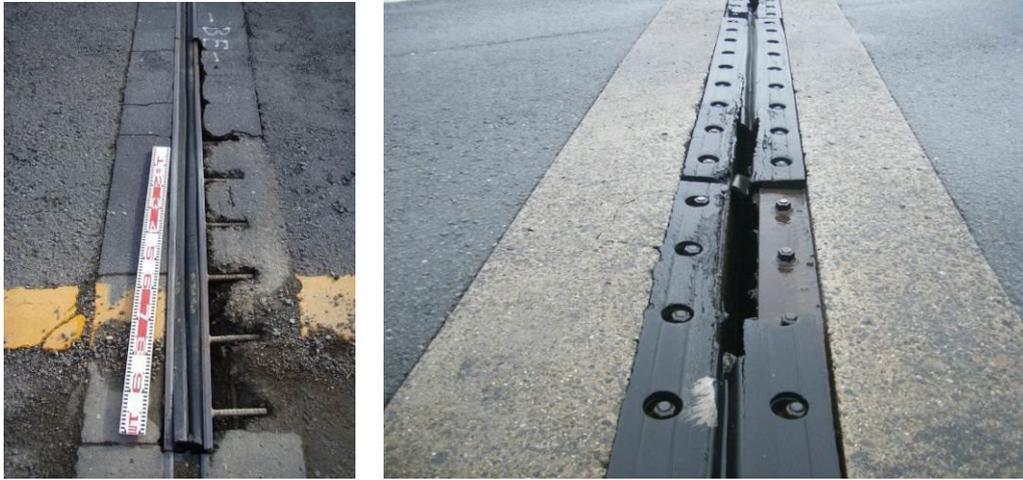
図 3.1-20 損傷ジョイントの様子
