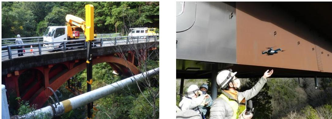
図 3.1-5 橋梁の点検実施状況
