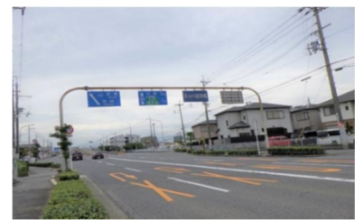
門型標識 (府道40号線/岸和田市)
