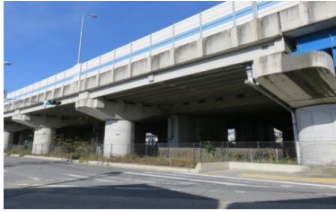
橋梁 神田高架橋(176号線/池田市)
