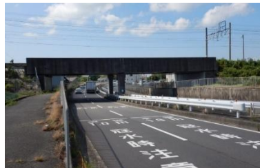
大型カルバート 岡中地下道 (泉佐野岩出線/泉南市)
