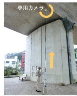
支承部の点検
