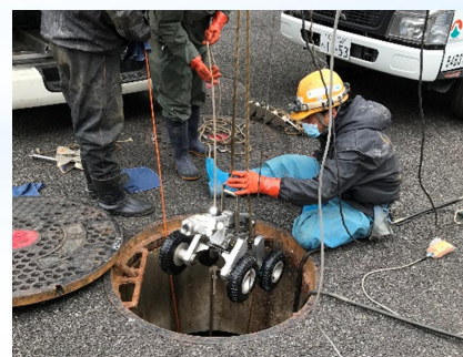
詳細点検状況 (TVカメラ調査)
